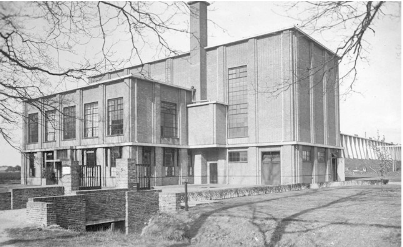
Afb. 24 Het NSP gezien vanaf de voorzijde. De instrumentmakerij, waar Boas werkte, was gevestigd op de eerste verdieping, achter de hoge ramen. Rechtsachter het begin van de sleeptank.
